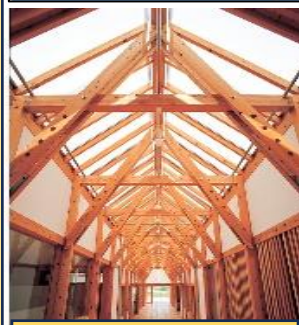
社屋コリドール（回廊）
