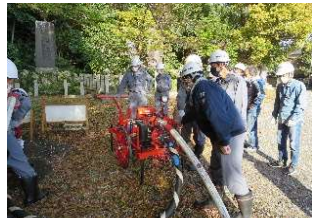
ポンプ点検 4月10日(日) ※ 毎月第2日曜日に実施
