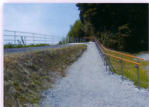
墓地登り坂の手すり設置
