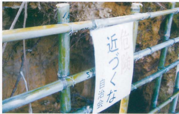
上の山公園危険箇所防護柵設置
